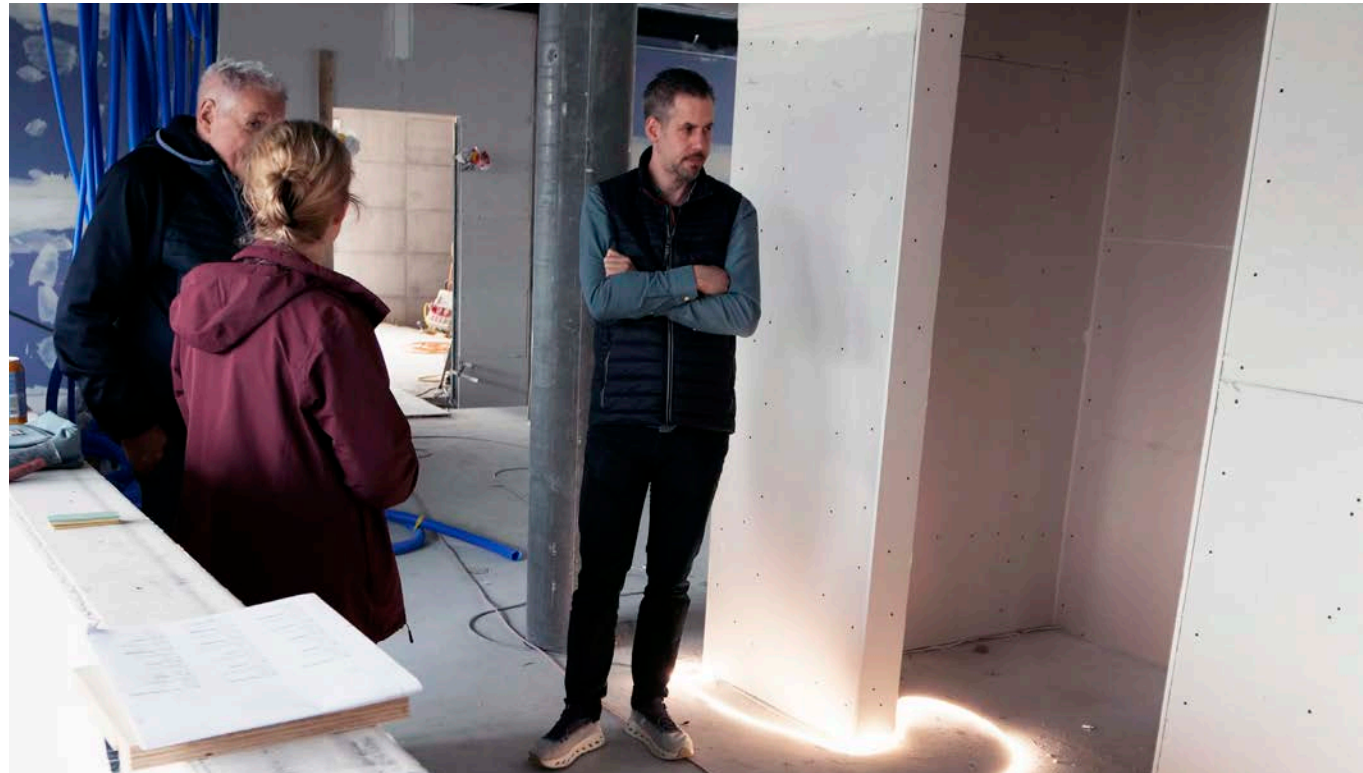
Johannes Kampfer informiert sich auf der Baustelle über den Baufortschritt.
